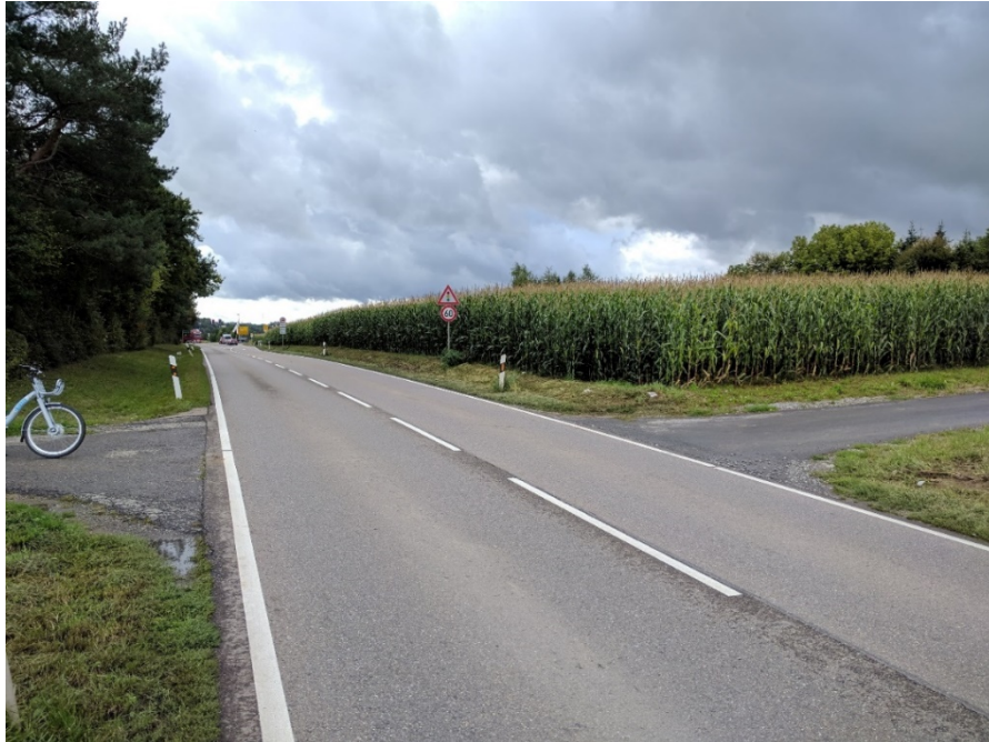
Bild: Querung L1100 auf Höhe Spielplatz im Nordwesten von Neckargröningen, Foto: Philipp Böhme
